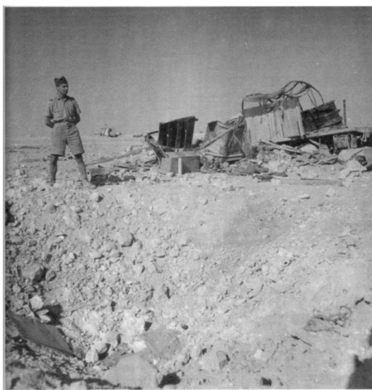
Dégâts après un bombardement aérien
